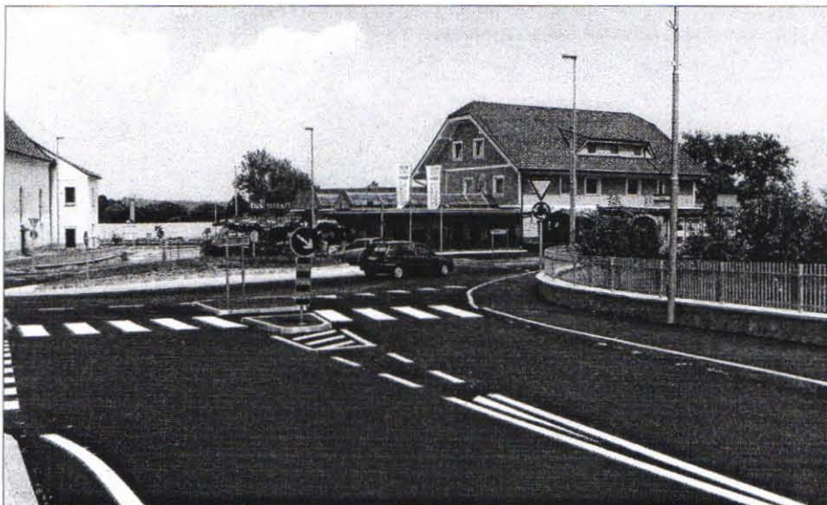
Največji zaključen projekt minulega leta je urejeno krožišče v centru Trnovske vasi, ki je ob tem dobil še kanalizacijo, pločnike, javno razsvetljavo in avtobusne postaje.
